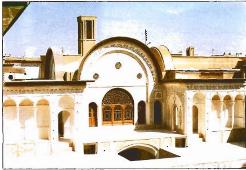
(منزل خانواده طباطبائی در کاشان) بازسازی شده توسط شهرداری کاشان
